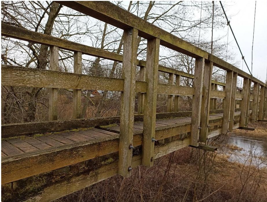
4 pav. Pėsčiųjų liepto medinės konstrukcijos
